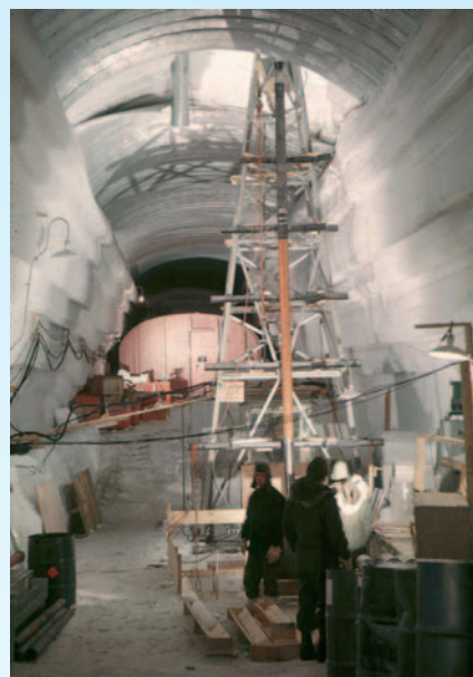
Iskerneboreudstyret monteret i en ishule i Camp Century-lejren.
